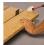
Abschlussdiele montieren
