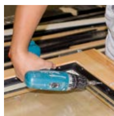
FIXclip-Schiene verschrauben oder nageln
