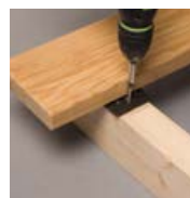
Verschrauben Lagerholz
