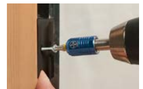
Verschraubung mit KNAPP® SK-Edelstahlschrauben 3,5x25 mm mit Bohrspitze
