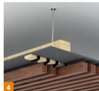
4 Leisten auf die Klammer aufstecken. Kleber abbiegen lassen.
