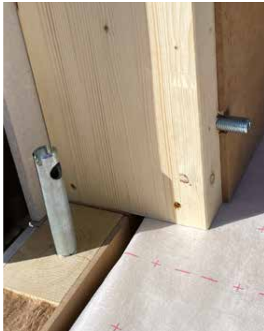
Wandanschluss im Test: Im Übungshaus wurde auch das Wandanschlusssystem zunächst im Hinblick auf die praktische Einsatzfähigkeit getestet.
