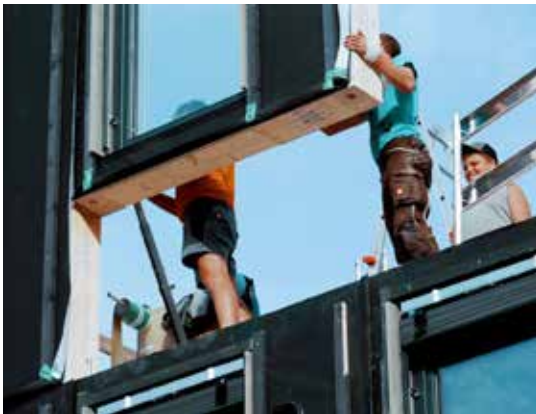
Die integrierte Montagehilfe ermöglicht den punktgenauen Anschluss.
