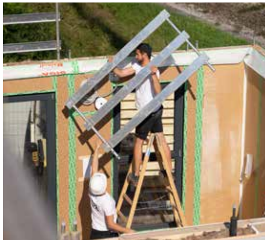
Die Absperrung wird direkt auf die Walco Pipe Verbinder aufgesteckt.
