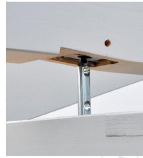
Montage mit Walco® Bolt: Die Sparren werden auf die Bolzen der unteren Grundplatten aufgesetzt und die Verbindung mit Spannbolzen gesichert.
