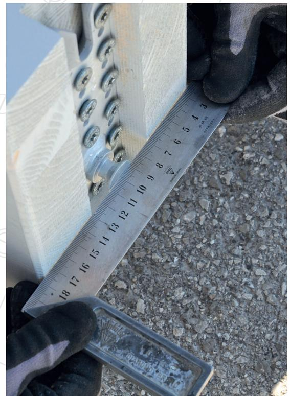
Ricon® S verbinden Pfetten mit Stützen und leiten die Querkräfte der Dachkonstruktion direkt in die Stützen ein.
