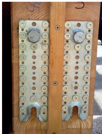
Für Lastabtragung und Verdrehmoment wurden zwei RICON® S nebeneinander montiert.
