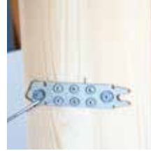
Sperrbügel montieren
