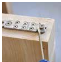
Sperrbügel montieren
