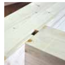
Gesicherte Verbindung durch Sperrbügel
