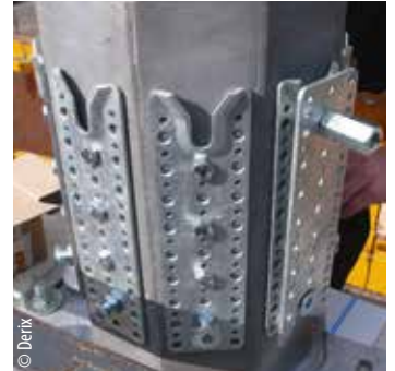
Firstknoten für Kuppeldach
