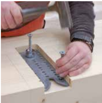
Schrauben ansetzen
