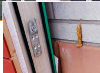
Montagebeispiel: Montiert an Wandelement mit beidseitigen Dichtungen.
