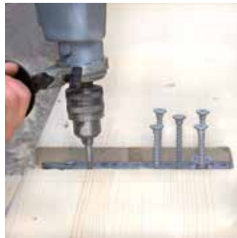
RICON®S im Hauptträger verschrauben
