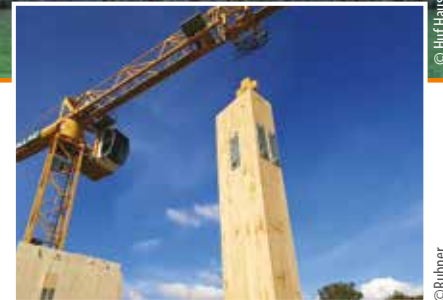
Montagebeispiel: Stützenanschluss, Projekt Sky Sophia in Süd Frankreich.
