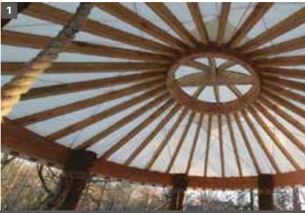
1 Schrägschlüsse Sparren an der Kuppel verschraubt mit T-JOINT.
