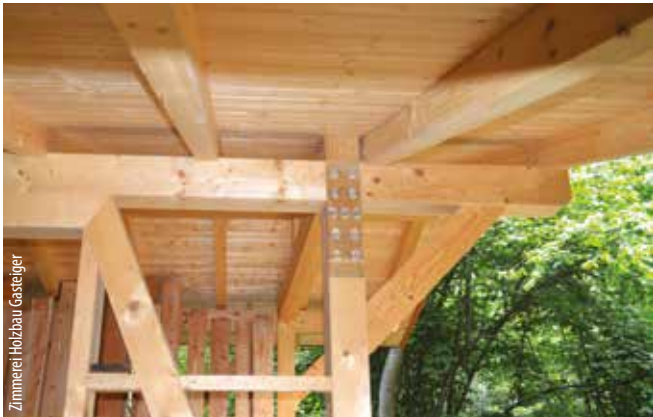
T-JOINT D35/W30 befestigte Laubholzlaschen von BSH-Zugstößen.
