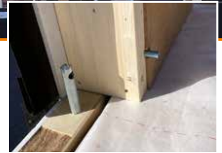
Detail: WALCO® PIPE Wand-Wand Verbindung
