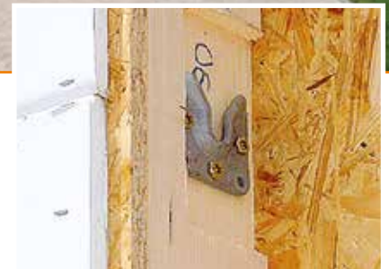
Montagebeispiel: Wandverbindung
