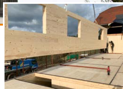
Exemple de montage : jonction de murs CLT.
