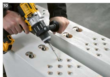
7 Jonctions de faitage, chevrons-poutres principales, rigides à la flexion avec T-Joint D40/W30.
