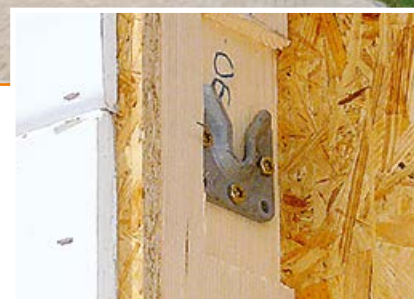
Exemple de montage : ferrure encastrée sur un montant
