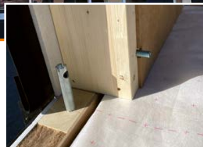
Exemple de montage : Pipe System - jonction mur-mur
