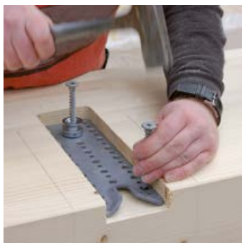
Positionnement des ferrures et vis
