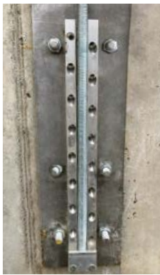
Assemblage MEGANT® sur support béton.
