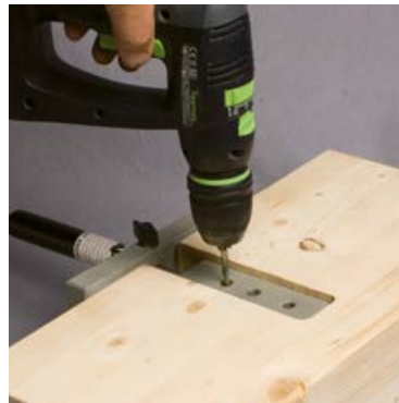
Pré-perçage poutre principale
