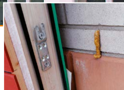
Exemple de montage : WALCO® Z40 sur montant d'ossature bois avec doubles joints
