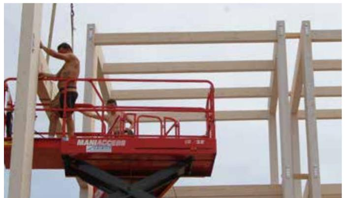
Montage d'une structure poteaux - poutres avec RICON®S
